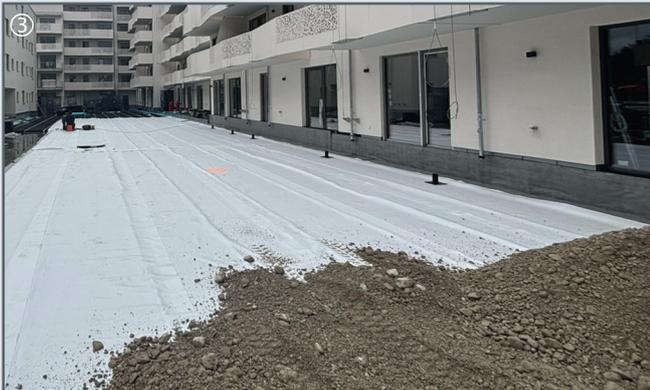
3 Die Schutzfliese abgedeckten Retentionsboxen werden mit Schotter und Bodenmaterial bedeckt
