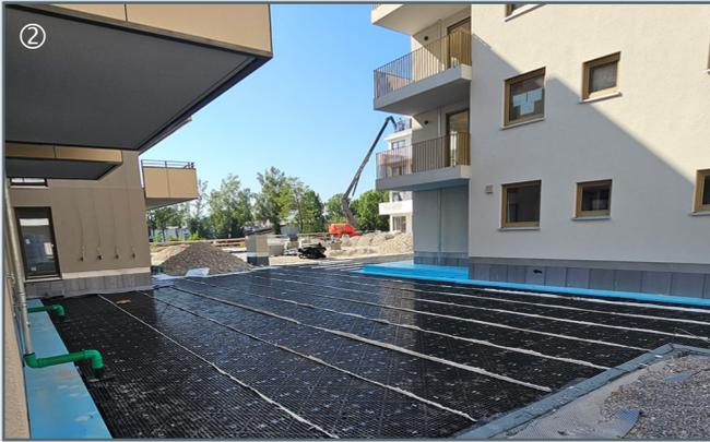
2 Retentionsboxen mit Kapillarfleece auf dem Dach der Tiefgarage, Ableitungen von den Balkonen
